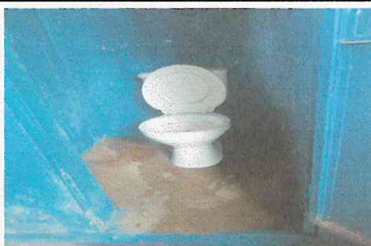
Foto 2: Sustitución de azulejo a 4 sanitarios.
