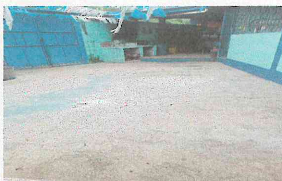
Foto 4: Reparación de losa de patio a sustitución de piso antideslizante.
