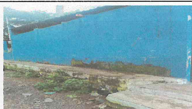
Foto 4: Reparación de banqueta de concreto.
