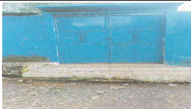
Foto1: Mantenimiento de portón de metal.
