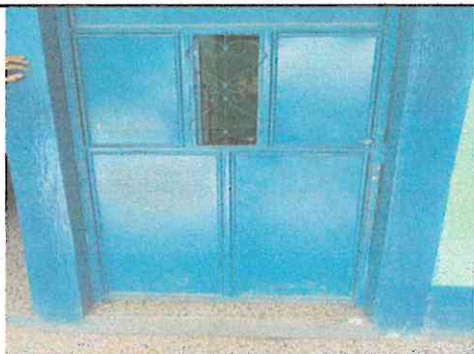
Foto 1: Mantenimiento a puertas de metal de aulas y sanitarios.
