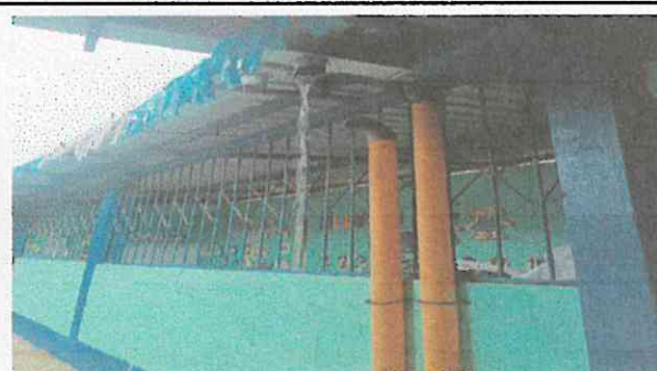
Foto 6: Mantenimiento de balcones de 3 aulas.
