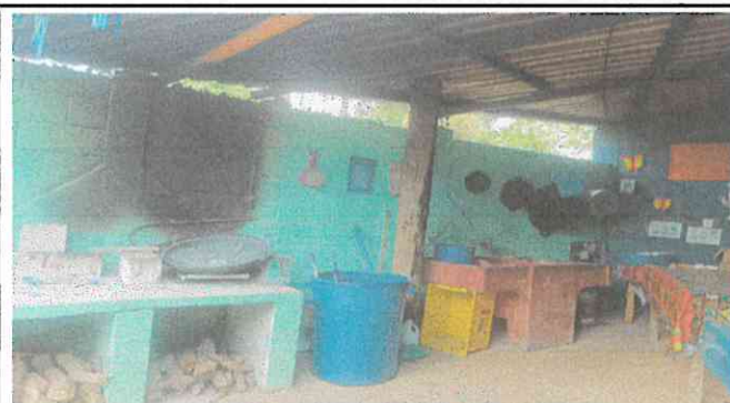
Foto 3: Sustitución de concreto por piso en cocina.
